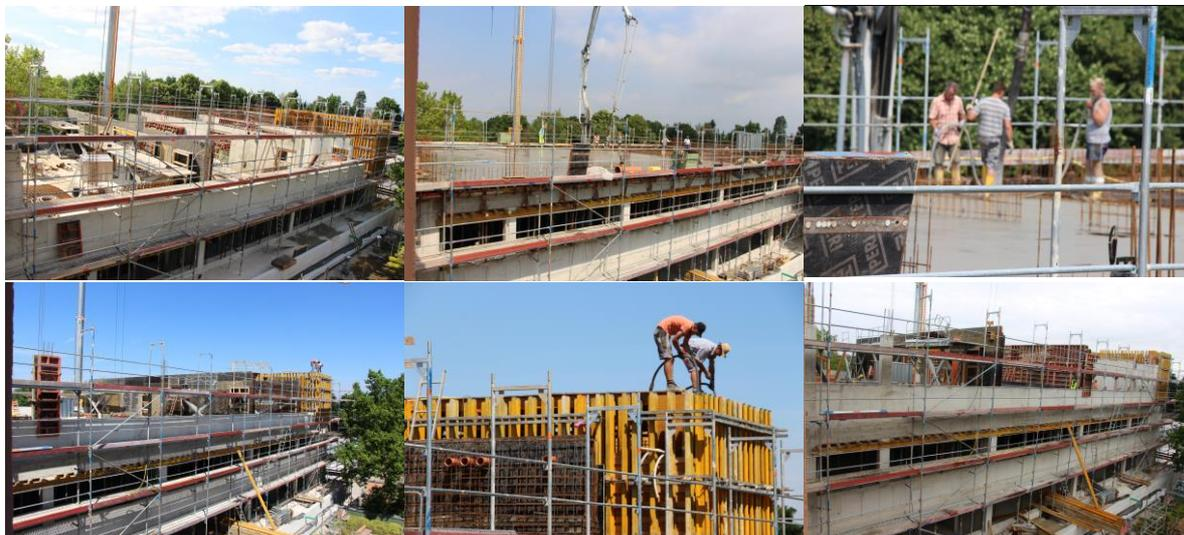
Mit dem Betonieren der Zwischenwände im zweiten (1. Reihe, linkes Bild) und dritten Stockwerk (Bilder in der 2. Reihe) sowie der 3. Decke (1. Reihe, Bild in der Mitte und rechts) nähern wir uns dem Ende der Rohbauphase. Die letzte Decke wird in der 1. Ferienwoche betoniert und damit der Rohbau abgeschlossen. Mit den Dachdeckerarbeiten beginnen in den Ferien die Ausbaurbeiten, so dass auch einem Richtfest im Herbst nichts mehr im Wege steht.
